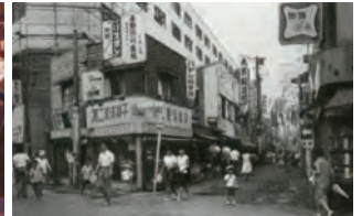
1963年 建設中の「三鷹ショッピングセンター」
